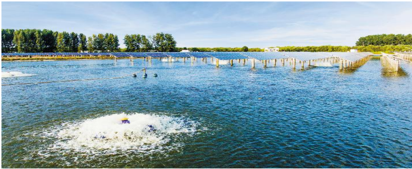
通威扬州“渔光一体”基地
