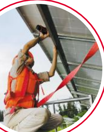
台山电站运维人员紧固螺栓
