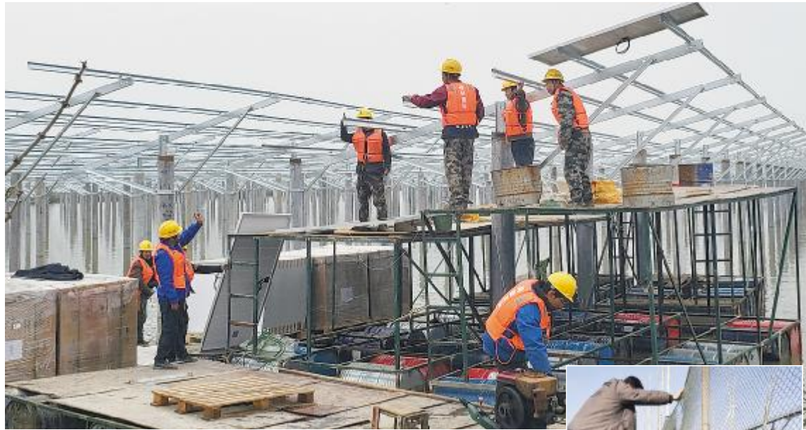
通威常德“渔光一体”工程建设部狠抓项目建设执行
