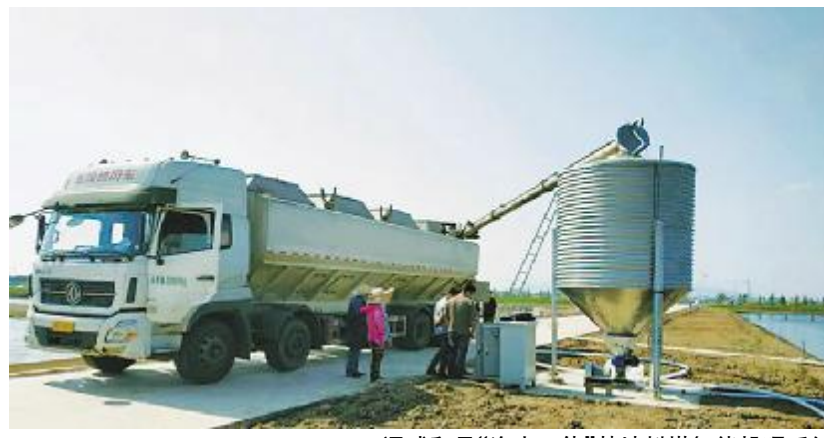
通威和县“渔光一体”基地料塔智能投喂系统
