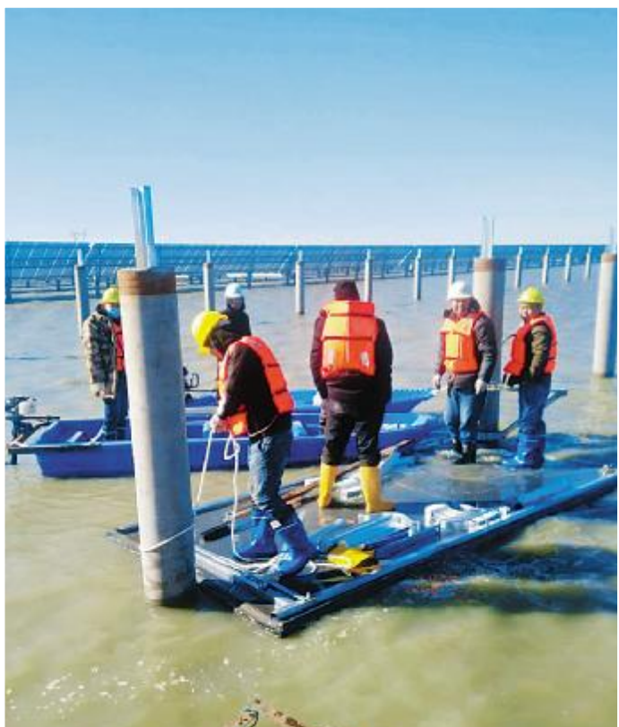
乾安项目部破冰抢施工
